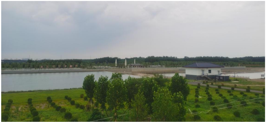
曹店橡胶坝段主槽
