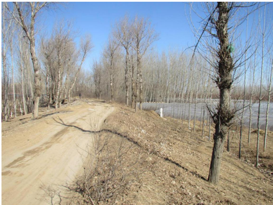
左堤堤防现状
